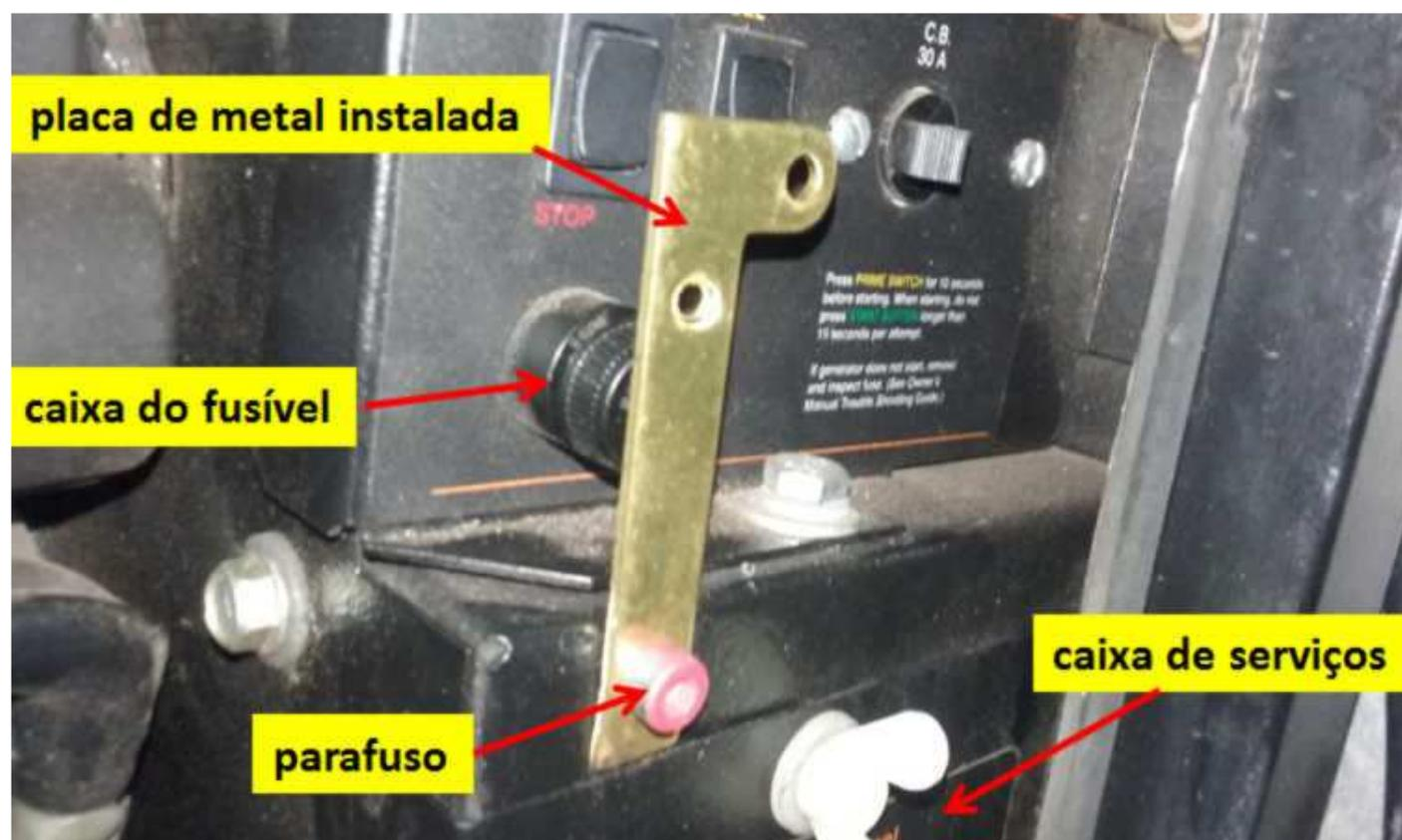
Figura 2 – Placa de metal instalada para evitar o afrouxamento da caixa do fusível
